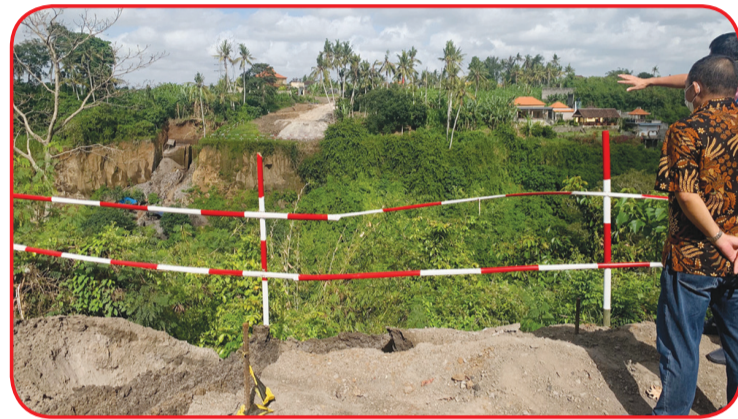
Proyek "High-altitude Glass Bridge" di Gianyar, Bali yang sedang dikerjakan.
